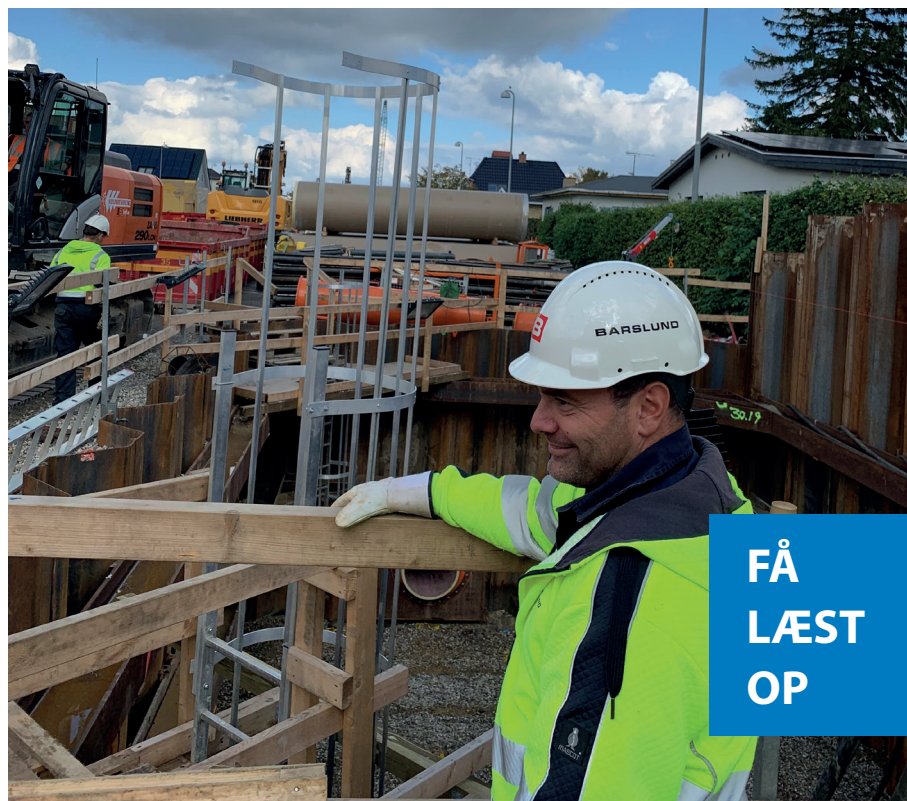
Maskinfører Michael Havmand foran en af de mange udgravninger.
