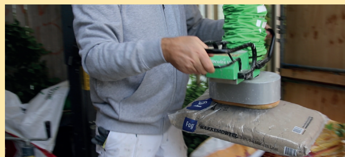
Mørtelsæk løftes med vakuumsuget.
